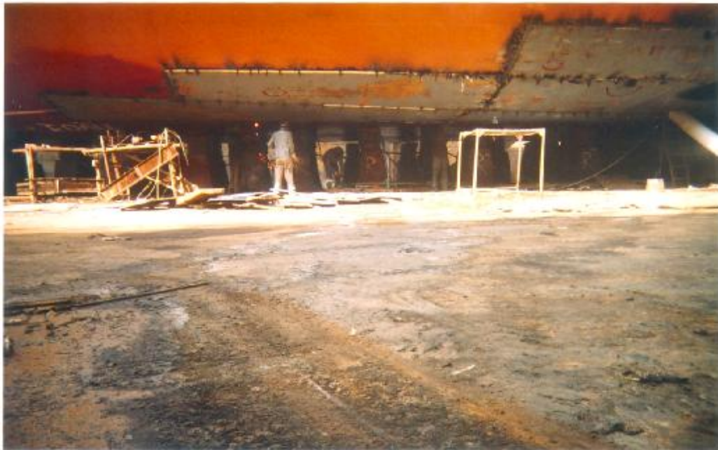
Hình 3.3: Ảnh chụp một số tấm tôn khu vực đuôi được thay mới.
